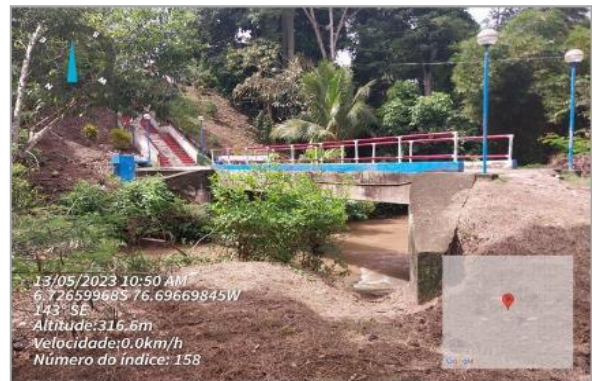
Daño probable a los estribos y debilitamiento de la estructura
