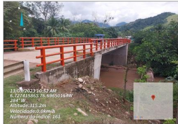
Daño probable a los estribos y debilitamiento de la estructura
