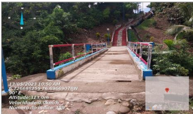
Daño probable a los estribos y debilitamiento de la estructura
